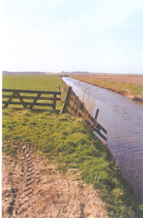
De hoofdvaart die het water vanuit het Hoornder Nieuwland afvoert naar het gemaal loopt dwars door de percelen van het bedrijf.
